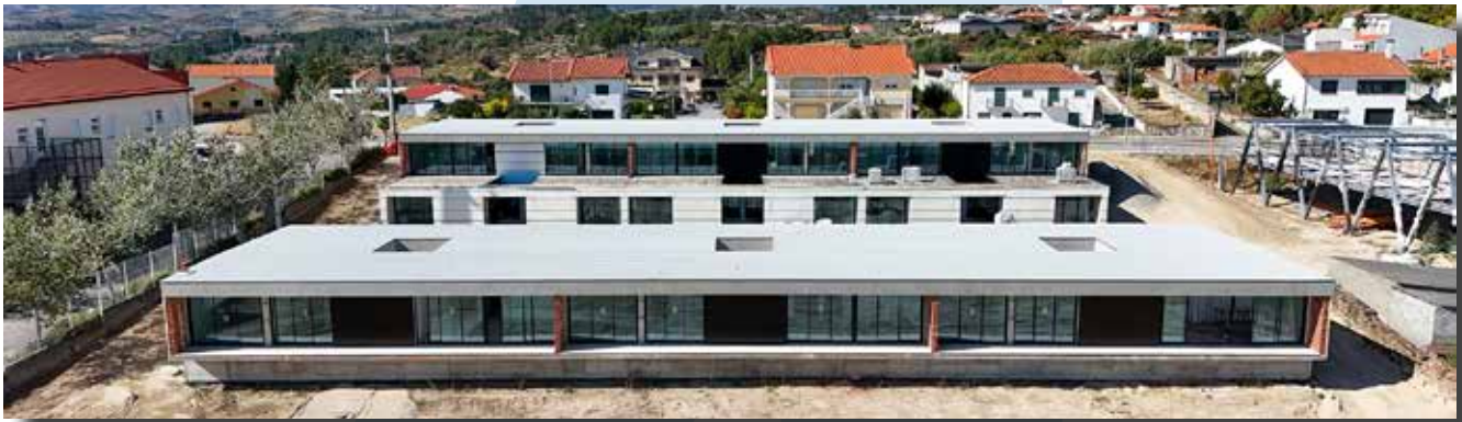
Complexo Residencial do Pinheiro Manso - Habitação Colaborativa
