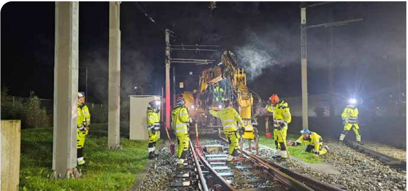
Trabalhos de manutenção, Bergen, Noruega
